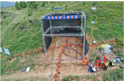
宁夏固原市隆德县陈新乡民联村 野外试验现场
